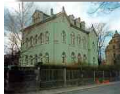
Sanierung Kindertagesstätte Nöthnitzer Str., Dresden
