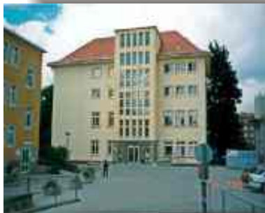
Sanierung Frauenklinik Universitätsklinikum Dresden (Denkmal)
